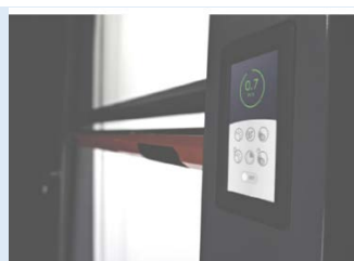
Sensore di controllo e monitoraggio del flusso d'aria Q-Flow Advanced
