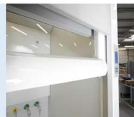
Telaio per saliscendi in fibra di legno MDF con due pannelli di vetro scorrevoli oppure in alluminio con singolo pannello di vetro
