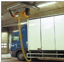
Arrotolatore motorizzato con riduttore per il riavvolgimento del tubo (220/380V - 3fase -0,37kW) e ingranaggio ad alto momento torcente.
