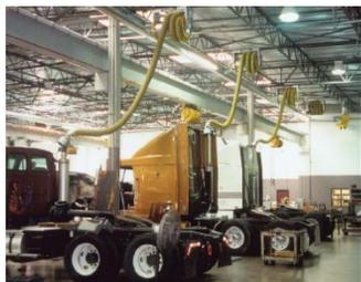
Arrotolatore motorizzato con motore 220V 1fase (0,44kW), da utilizzare per l'aspirazione dei gas di scarico da auto, moto, furgoni...
