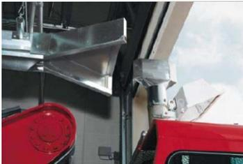
La canalina VSR è la soluzione ideale per aspirare i gas di scarico dei veicoli di emergenza/pronto intervento che hanno la marmitta con scarico alto, verticale.
